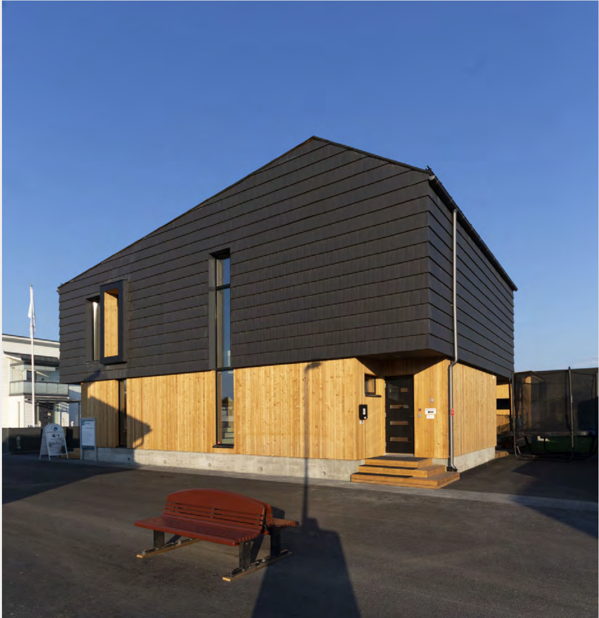
Talo Haltiattaren julkisivussa on käytetty lehtikuusta ja sementtitiiliä (Suomen asuntomessut, 2008).
