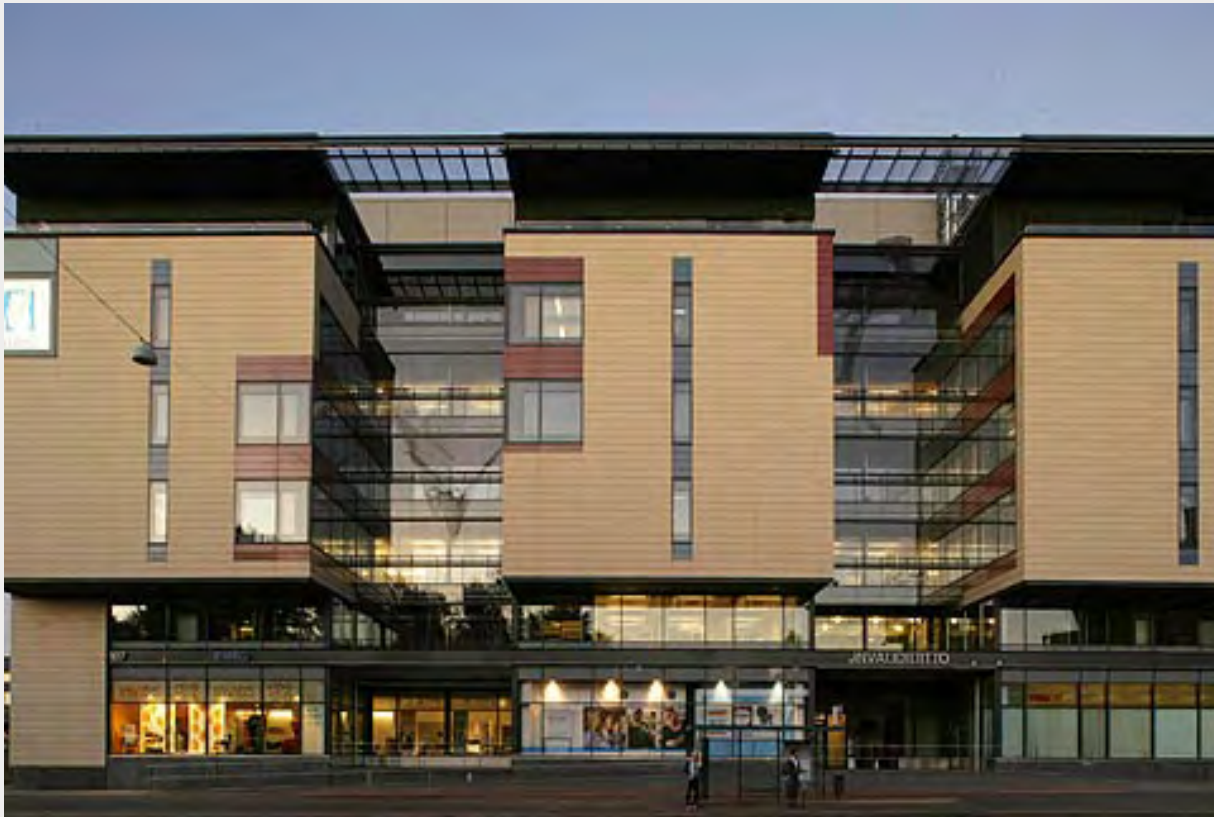
Invalidiliiton esteettömän toimitalon julkisivu Mannerheimintien suuntaan Helsingissä (Arkkitehtitoimisto Hannu Jaakkola, 2011).
